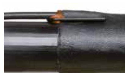
Přerušené propojení stínění pro transpozici
