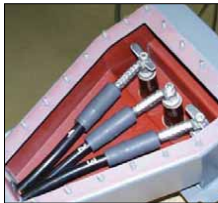
Svorkovnicová skříň motoru vn připravený k naplnění ekologickou zalévací hmotou Guroflex MV
